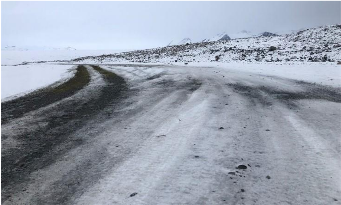
Mynd 83. Þar sem kantröstunum eftir hefilinn sleppir eru slóðir farnar að myndast utan við um leið, hér má sjá í gróðurtorfur í hjólfarinu vinstra megin.
