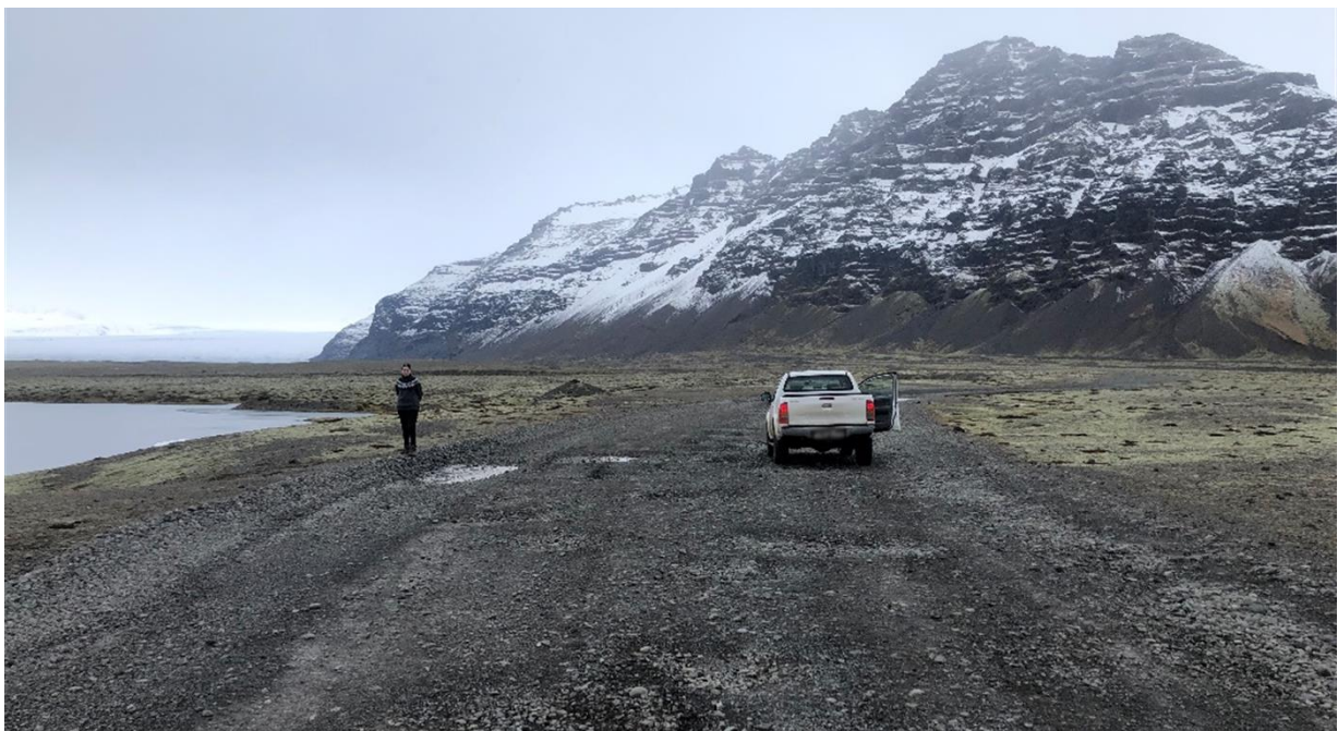
Mynd 67. Dæmigerð breidd á slóð í flokki 4, >9 m. Þarna er slóðin nánast fjórbreið miðað við venjulegan jeppa.
