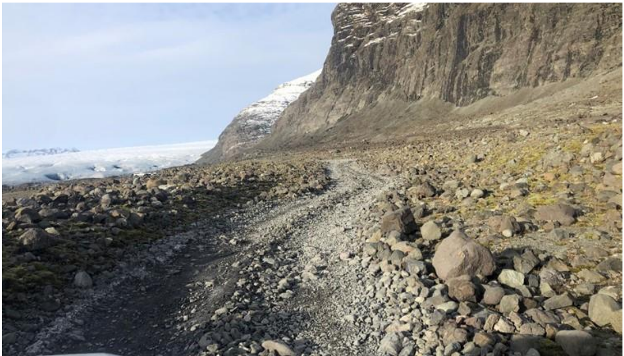
Mynd 77. Eftir því sem innar dregur þrengist slóðin og efnið verður grófara, það heldur því örlítið betur við útvíkkunina.
