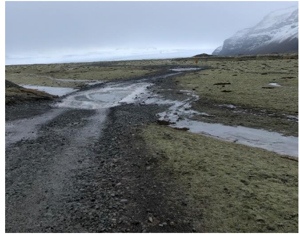
Mynd 63. Lækur meðfram malarhjalli. Hér þarf ræsi ef slóðin verður lagaður.
