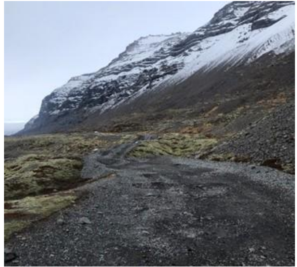
Mynd 74. Hér hefur verið fyllt í farveg, slóðin er gróf og ójöfn en breiddin eðlileg miðað við „slóð“.
