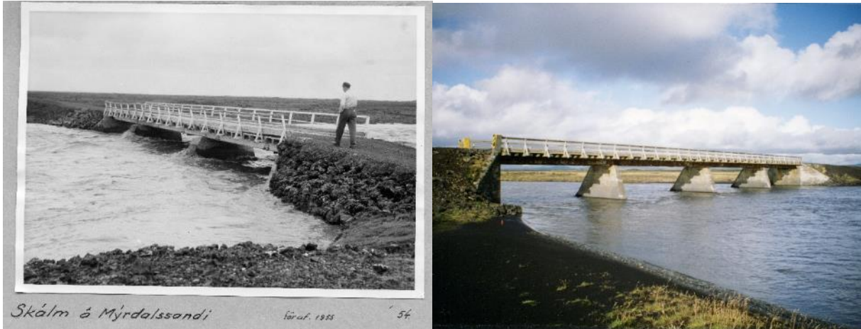
Myndir 14a-b. a) Brú yfir Skálm sem fór af í Kötluhlaupinu árið 1955. Ljós. Jón J. Víðis, 1954. Myndasafn Vegagerðarinnar. b) Brú yfir Skálm sem byggð var árið 1956 í kjölfar þess að hana tók af í Kötluhlaupinu. Ljós. Myndasafn Vegagerðarinnar.
