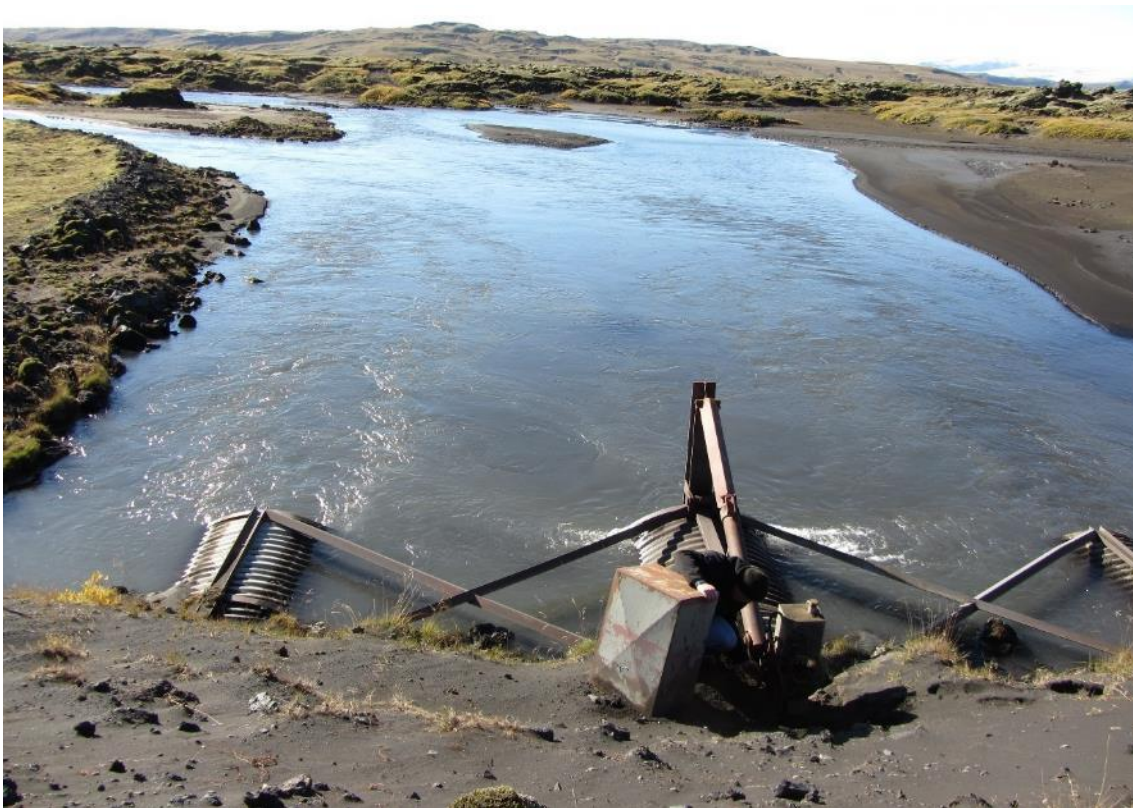
Mynd 7. Varnargarður við Árkvísar með þremur gegnumrennslisrörum sem veita vatni úr Skaftá út á Eldhraun. Veitan gengur undir nafninu Brestur. Ljós. Gústav M. Ásbjörnsson, september 2012.
