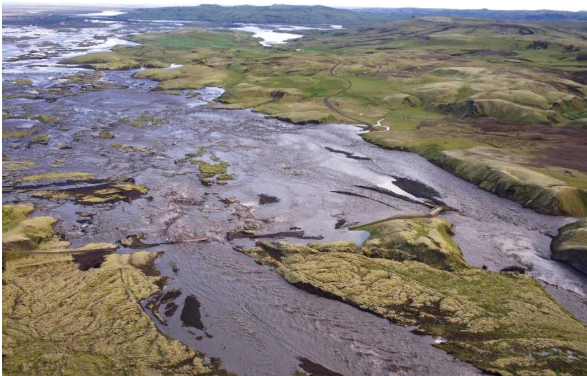
Mynd 32. Skaftárhlaup 2018, myndin tekin við Skaftárdal. Hlaupið tók í sundur veginn inn að Skaftárdal en brýrnar stóðu það af sér. Ljósmyndasafn Veðurstofu Íslands, ágúst 2018.
