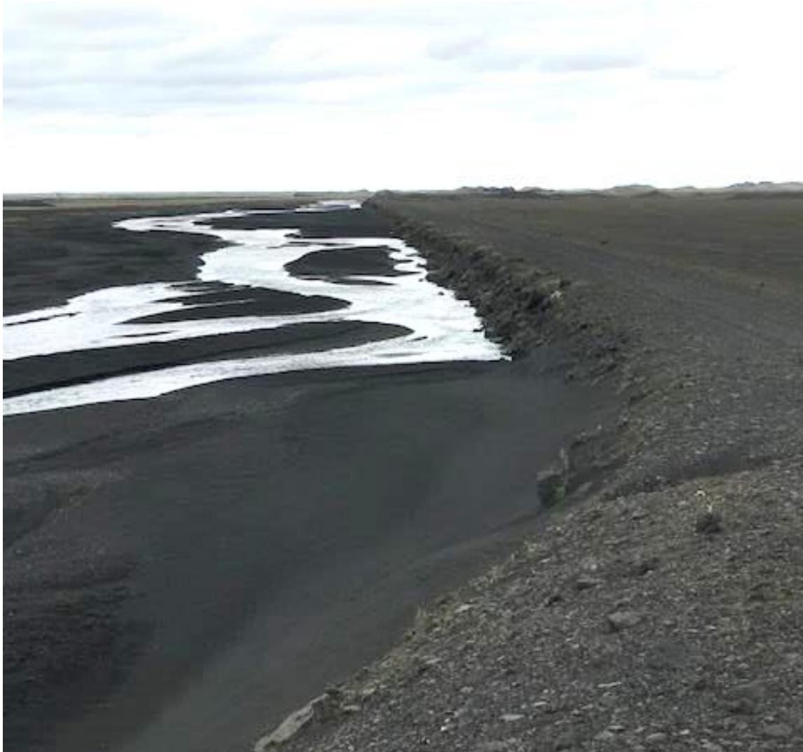
Mynd 43. Varnargarður á vesturbakka Skálmar. Ljósmynd. Pálína Pálsdóttir, júní 2019.
